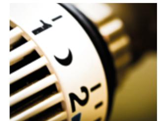
Die Position des Thermostatkopfes lässt sich per Hand einstellen. Der Nachteil eines klassischen Thermostatventils liegt auf der Hand: Jedes einzelne Heizungsventil im Gebäude muss individuell per Hand geregelt werden.
